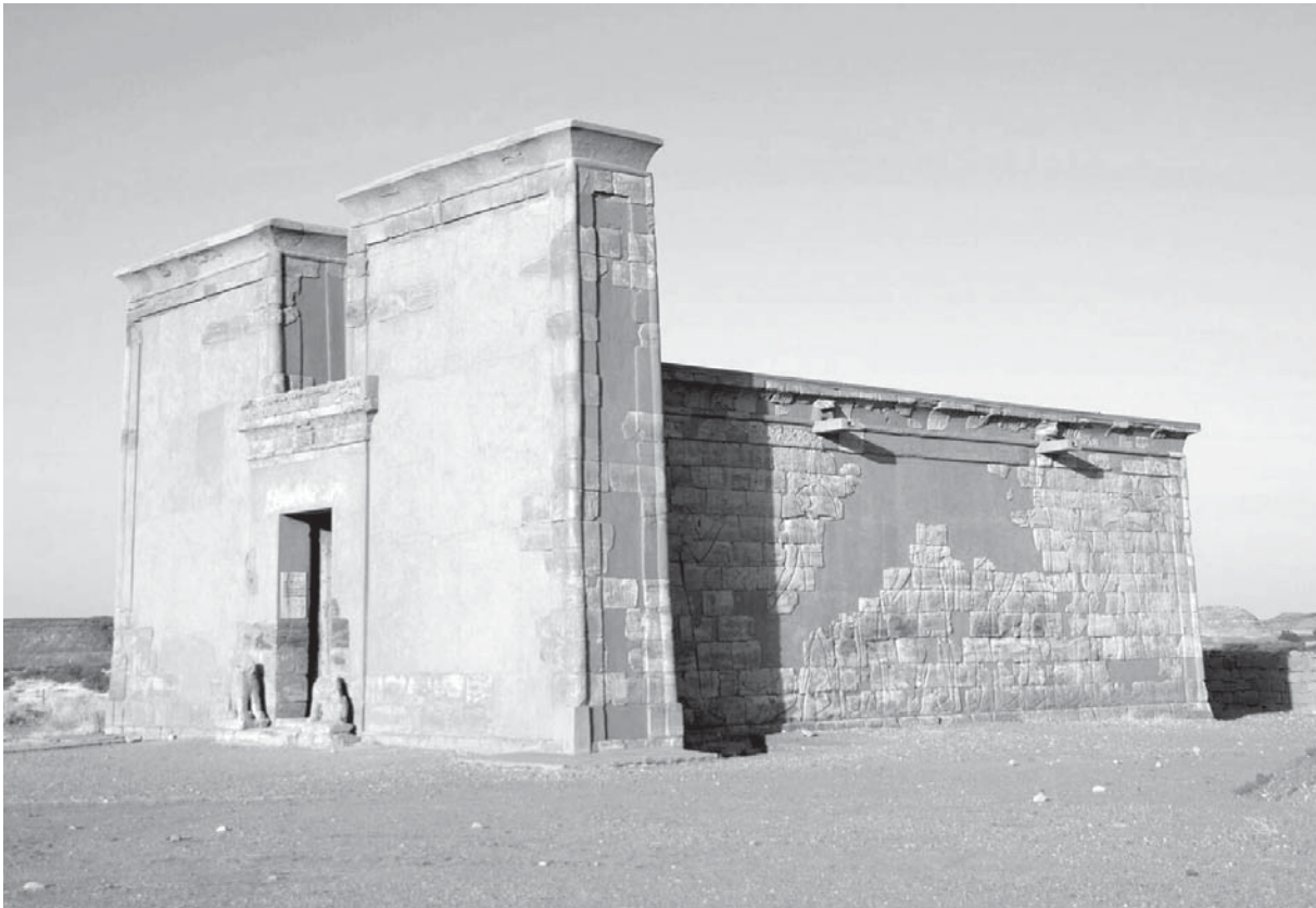
Abb. 1: Gesamtansicht des Tempels vor Beginn der Arbeiten (Foto: Peter Becker)
