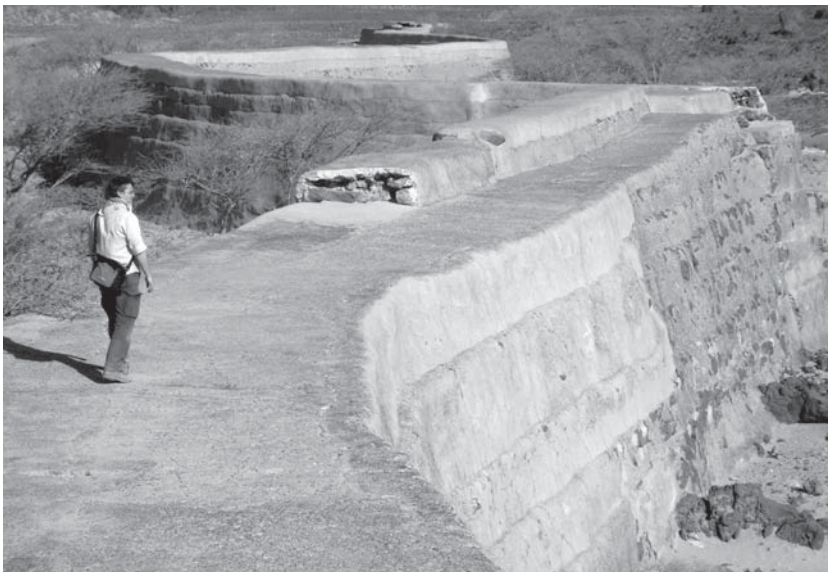
Abb. 4: Mauer C von Mabnā al-Ḥašrağ, Blickrichtung nach Nordwesten (Aufnahme: Ueli Brunner)
