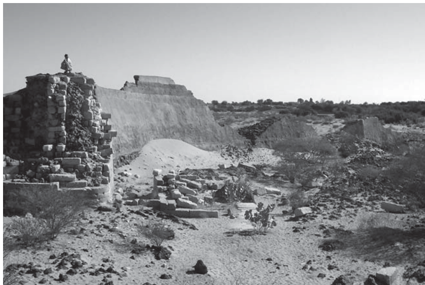
Abb. 5: Mauer D mit Auslass A2 im Vordergrund links, Blickrichtung nach Osten (Aufnahme: Ueli Brunner)
