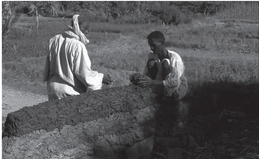
Abb. 12: Errichtung einer Mauer in der „galūs“ genannten Technik. Ausser den Händen kommt kein Werkzeug zum Einsatz.
