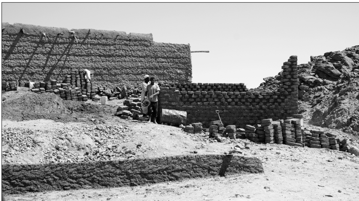
Abb. 7: Bau eines Hauses aus ungebrannten Lehmziegeln (März 2005).
