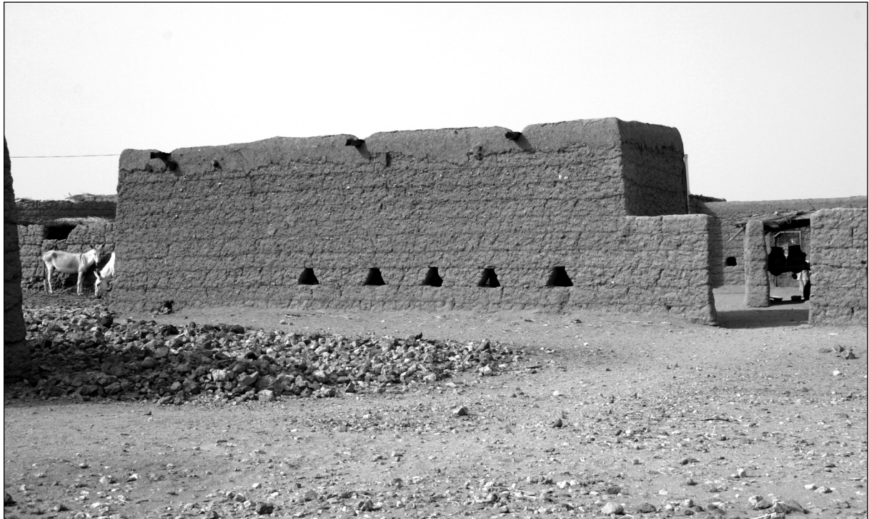
Abb. 3: Großes rechteckiges Gebäude (Küche und Veranda) aus Stampflehm mit rautenförmigen Fenstern: Hofanlage von Mohammed 'Ali Al-Khatim und Fatnah Ahmed Jusif in Neu-Atoyah
