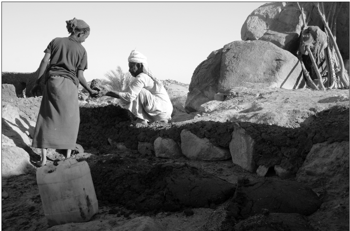
Abb. 10: Bau eines Hauses aus Stampflehm (März 2005).
