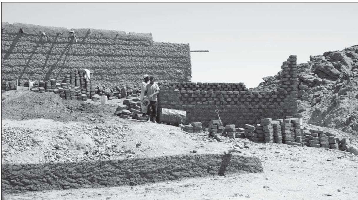
Abb. 7: Bau eines Hauses aus ungebrannten Lehmziegeln (März 2005).
