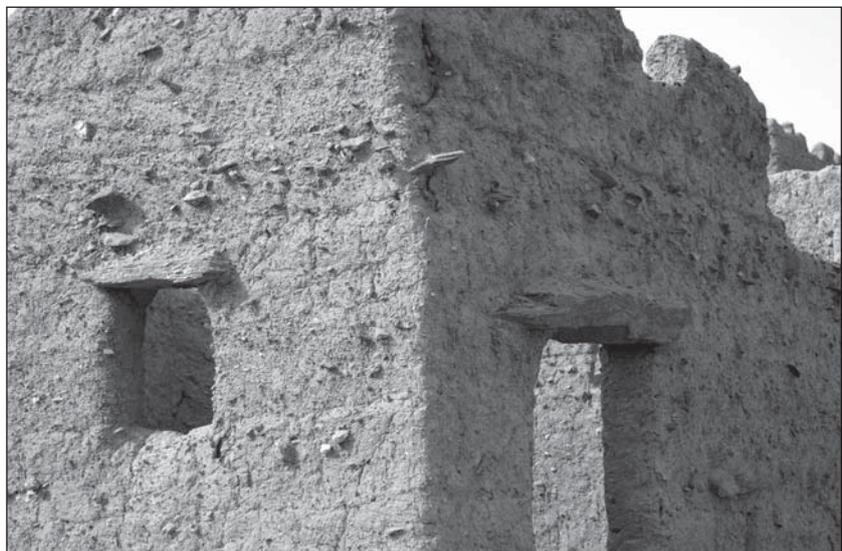
Abb. 4: Rechteckiges Gebäude aus Stampflehm mit hohem Steinanteil; Steinplatten über Fenster und Tür: Koranschule in Alt-Atoyah.
