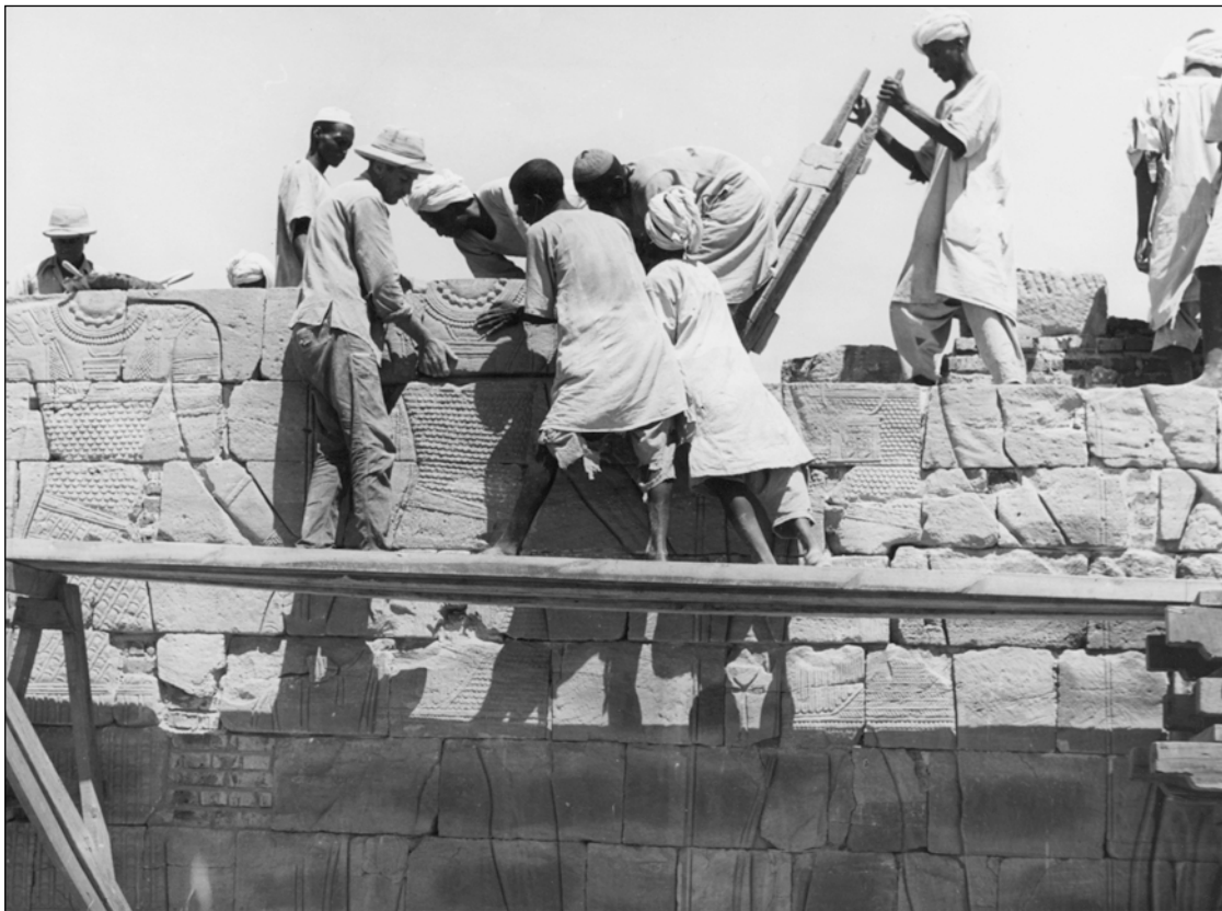
Abb. 1: Beim Wiederaufbau der Südwand des Löwentempels
