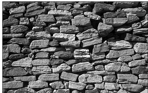
Abb. 5: Detail der Ostmauer.
