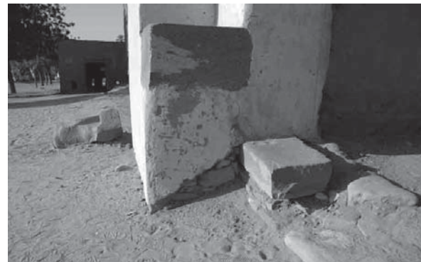
Abb. 4: Napatanische Grundmauer unter der Moschee von Qubbat el Hajj (Foto : T. Kendall). Links ist das Unterteil einer stark abgeriebenen Granitstatue zu sehen.
