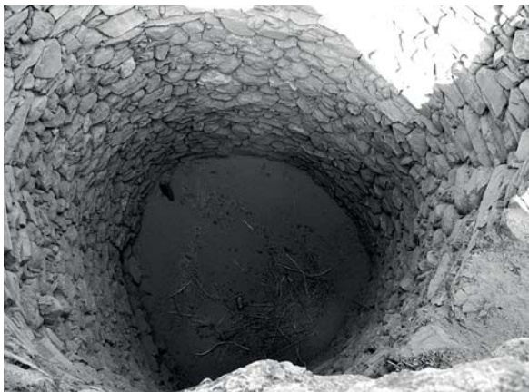
Abb. 2: Ein aus Steinen gemauerter Brunnen (Fotos: Lohwasser).
