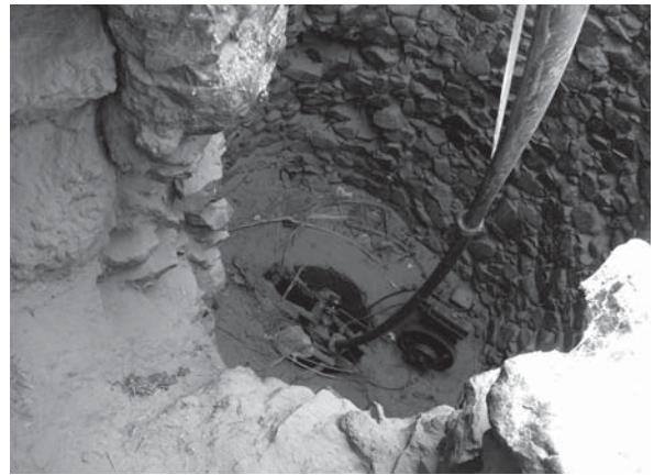
Abb. 10: Brunnen B mit oberer und zentraler Plattform
