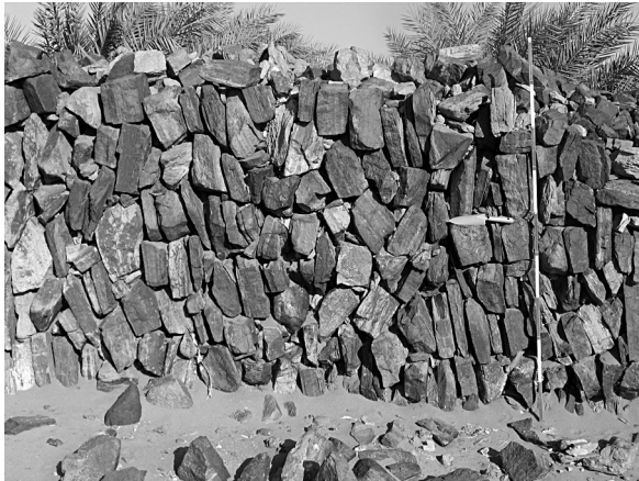
Abb. 9: MOG047: Detail des Trockensteinmauerwerks der östlichen Mauer (Foto: H.U.N.E.)
