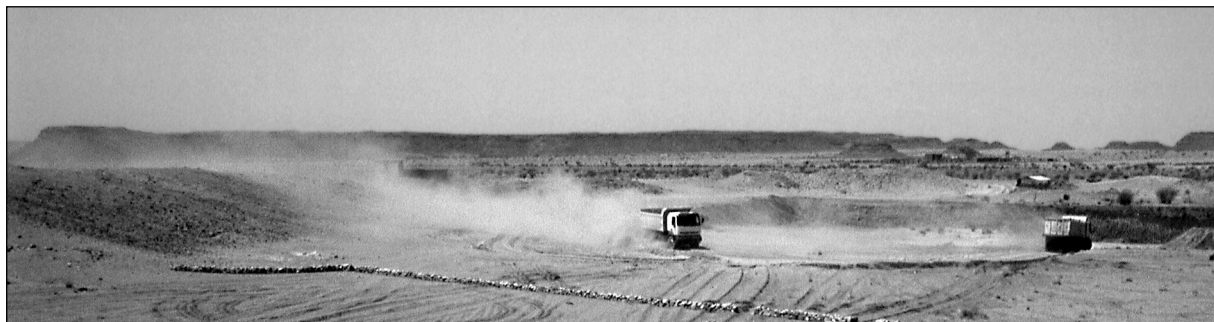
Abb. 9: Permanente Sand- und Staubausschwehungen in Richtung Löwentempel durch die Reaktivierung der Hafirsedimente infolge Ausbaggerung und Befahrung.
