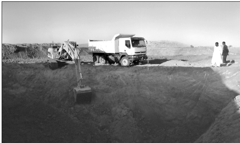
Abb. 16: Baggerarbeiten im Schnitt H-9 entlang der Hafirquerachse im Westprofil.
