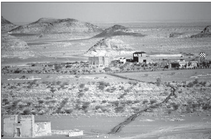
Abb. 27: Blick über den Löwentempel zur Westseite des Tales mit dem durch das SCI errichteten resthouse-Komplex, zu dem auch ein 2003 gebohrter Tiefbrunnen mit Wasserturm gehört. Von dort führt die in weitem Bogen verlaufende Wasserleitungstrasse zum Löwentempel.
