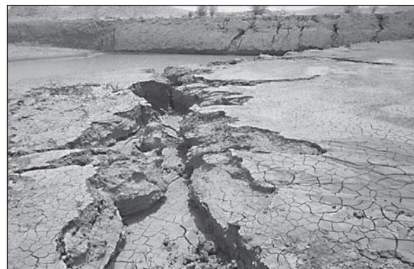
Abb. 10: Massive Erosionserscheinungen im Hafir nach den ersten Regenfällen im Juni 2005 (Foto: Zaroug Bakri Mohamed Ahmed, Inspektor NCAM).
