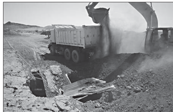
Abb. 17: Die Abbaggerung des 2004 sicherheitshalber mit Wellblech abgedeckten Schnittes H-8, dessen Umfeld wegen starker Ausspülungen, Einstürzen und Rissbildungen durch die Regenfälle 2004 nicht mehr betreten werden konnte.
