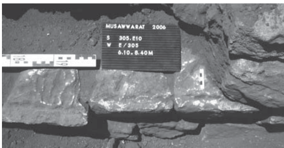
Abb. 34 Detail der Risslinie außen und daran orientierte Bossenblöcke der antiken Reparatur (rechts)
