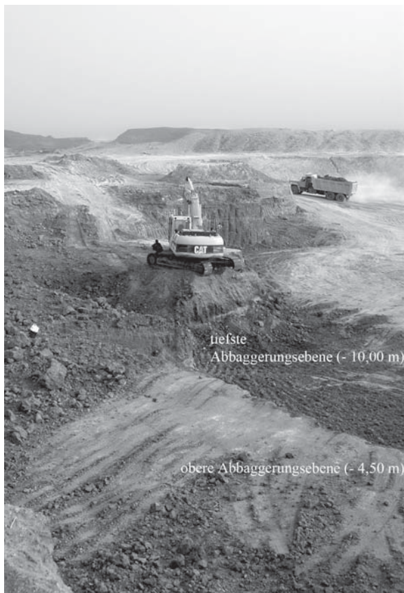
Abb. 53 Abbaggerungsebenen von Norden
