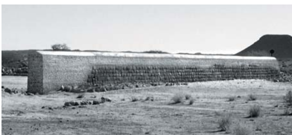
Abb. 13 M 305/415 vor dem Rückbau von SW
