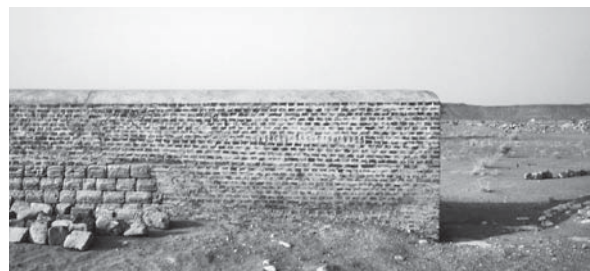
Abb. 14 Westl. Mauerende 305/415 vor dem Rückbau von N
