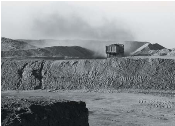
Abb. 56 Abgebaggerter Wallabschnitt im Süden mit Kippertrasse
