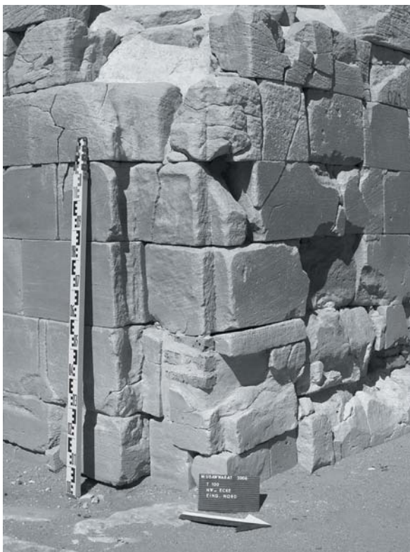
Abb. 45 Zentraltempel-Nordeingang, NW-Außenecke: restaurierter Zustand
