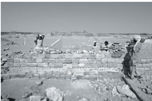
Abb. 23 Nordende der M 305/E im Robbau
