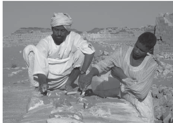
Abb. 17 Versiegeln der Mauer(füllung) mit Kalkmörtel
