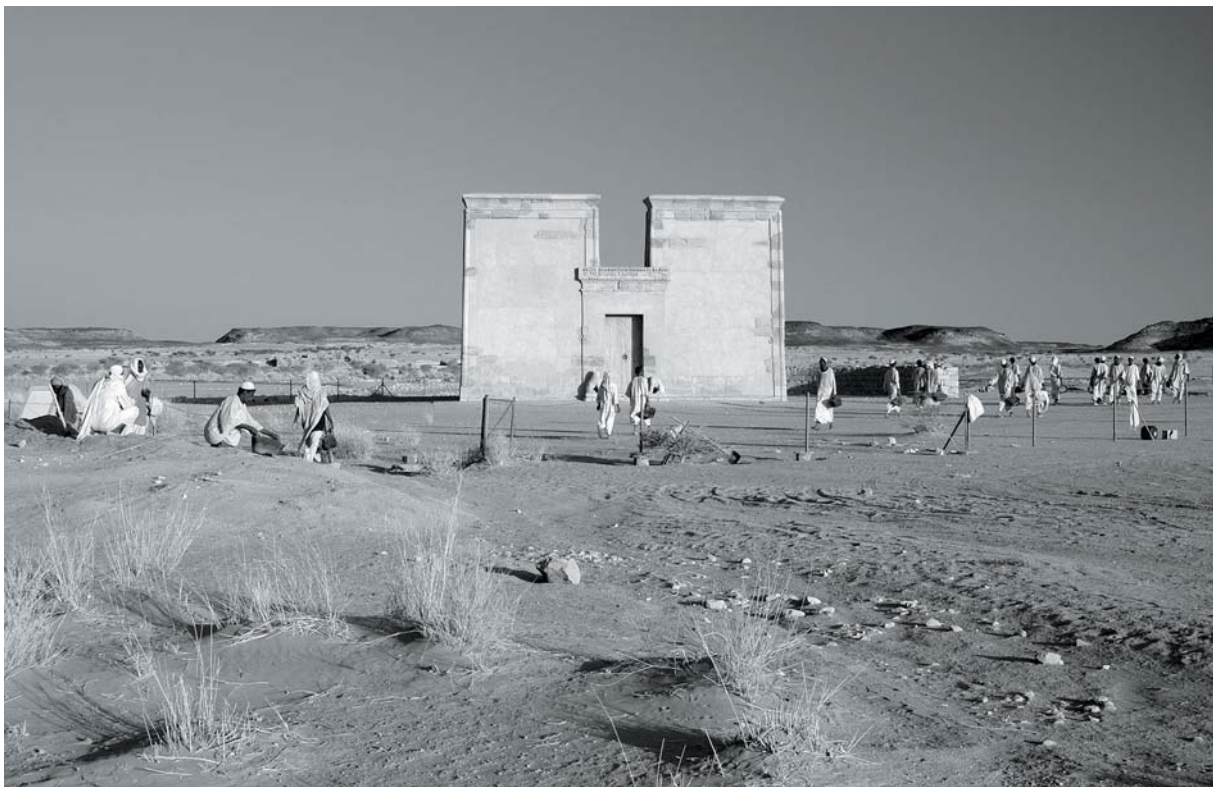
Abb. 51 Verfüllarbeiten am Löwentempel. Abraumberg und freigespülte Pfosten der Umzäunung und ihres Tores
