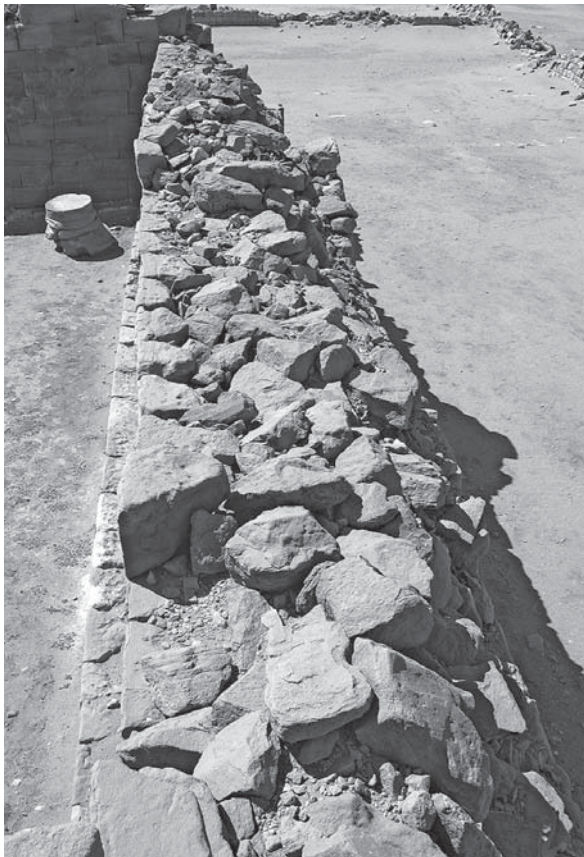
Abb. 33a: Die Mauerkrone der Westwand vor Beginn der Arbeiten. An der rechten Mauerkante der später reparierte oberste Block.
