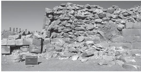
Abb. 34a: Die Ostfassade von Tempel und Vorbau im Bereich der SE-Ecke vor ihrer Sanierung.
