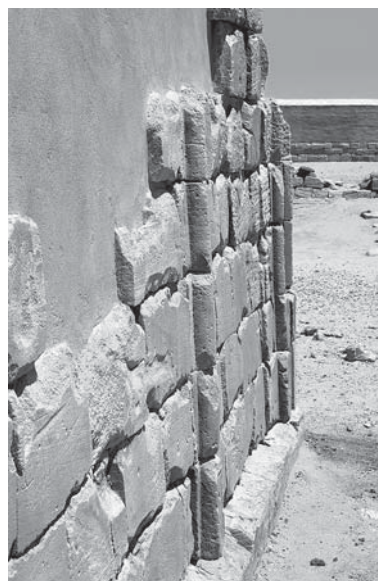
Abb. 18b: Derselbe nach Abschluss der Arbeiten 2007.
