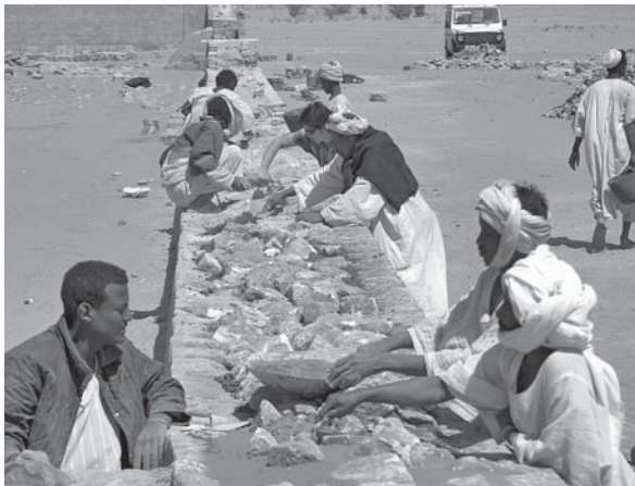
Abb. 7: Bei der Herstellung des neuen oberen Mauerabschlusses.
