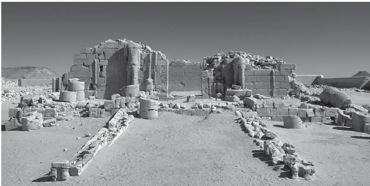
Abb. 12: Südfront und Vorbau des Tempels 300 vor Beginn der Sanierung.
