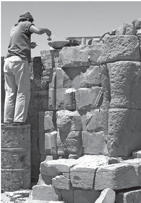
Abb. 28: R. Mucha beim Errichten der Ziegelaufmauerung an der Ostseite des Tempeleingangs oberhalb des Löwen.
