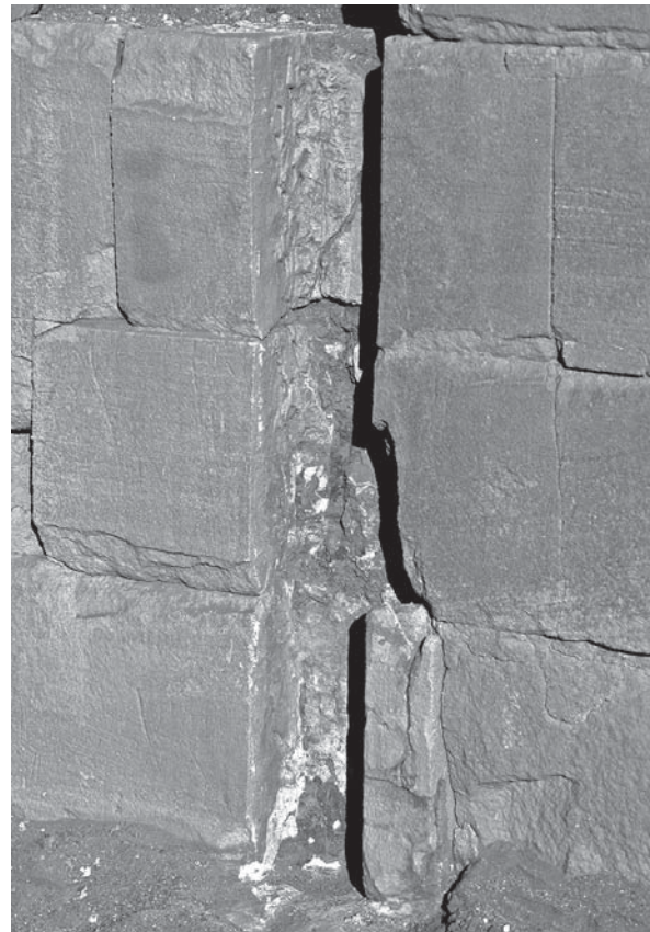
Abb. 20: Detail der westlichen Tempelmauer nach Abbau des nördlichen Rundstabes.
