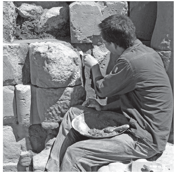
Abb. 25: Beim Verfugen und Retuschieren des Löwen und Südfassade.
