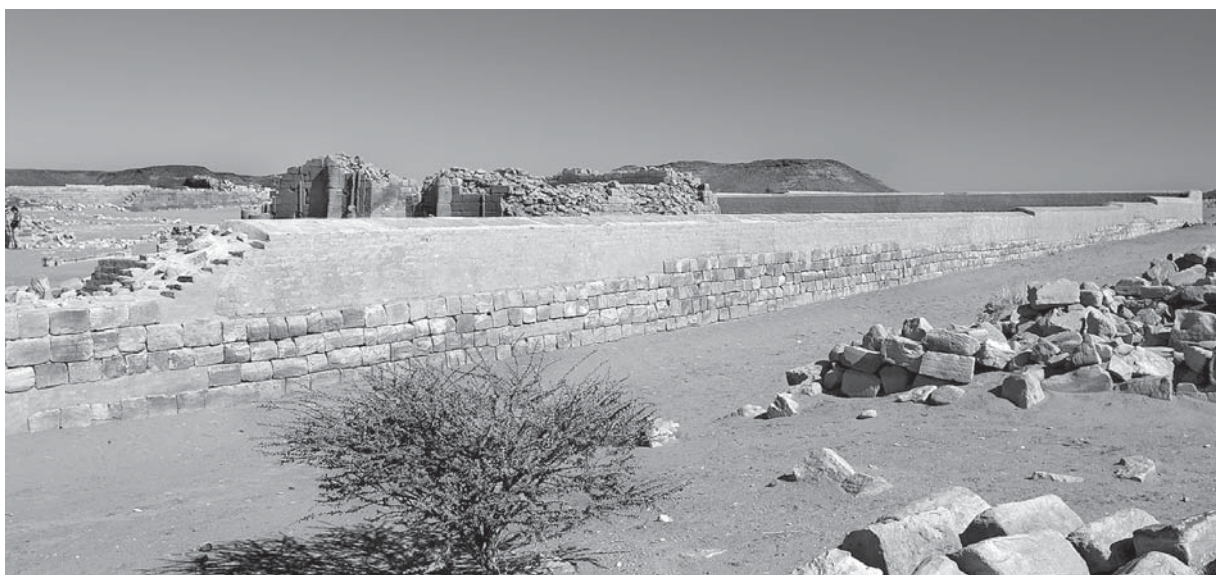
Abb. 5: Die Umfassungsmauer 304/E vor Beginn der Arbeiten 2007. Links das Nordende der 2006 nach neuer Konzeption sanierten Mauer 305/E mit einer verputzten Trennschicht (s. u.), im Hintergrund der Tempel 300.
