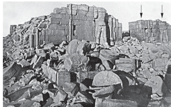
Abb. 14: Zustand der Südfassade mit Blockversturz 1906 (Foto: Braested, Archiv AKNOA).
