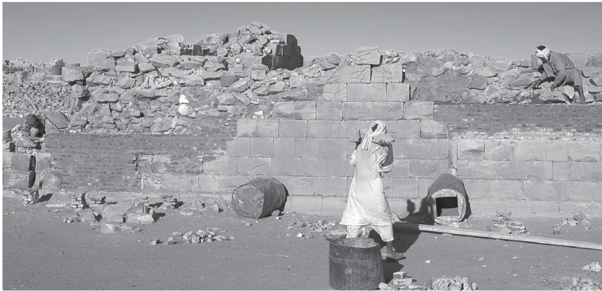
Abb. 21: Bei der Herstellung der Mauerfüllung an der Ostwand von Tempel 300.
