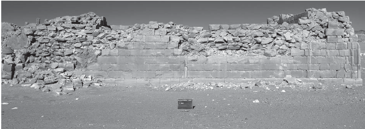
Abb. 11: Zustand der Ostseite von Tempel 300 vor Beginn der Arbeiten 2007.
