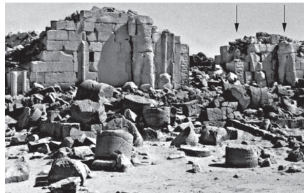
Abb. 15: Zustand der Südfassade vor den Arbeiten der 60er Jahre (Foto: Hintze, Archiv AKNOA).
