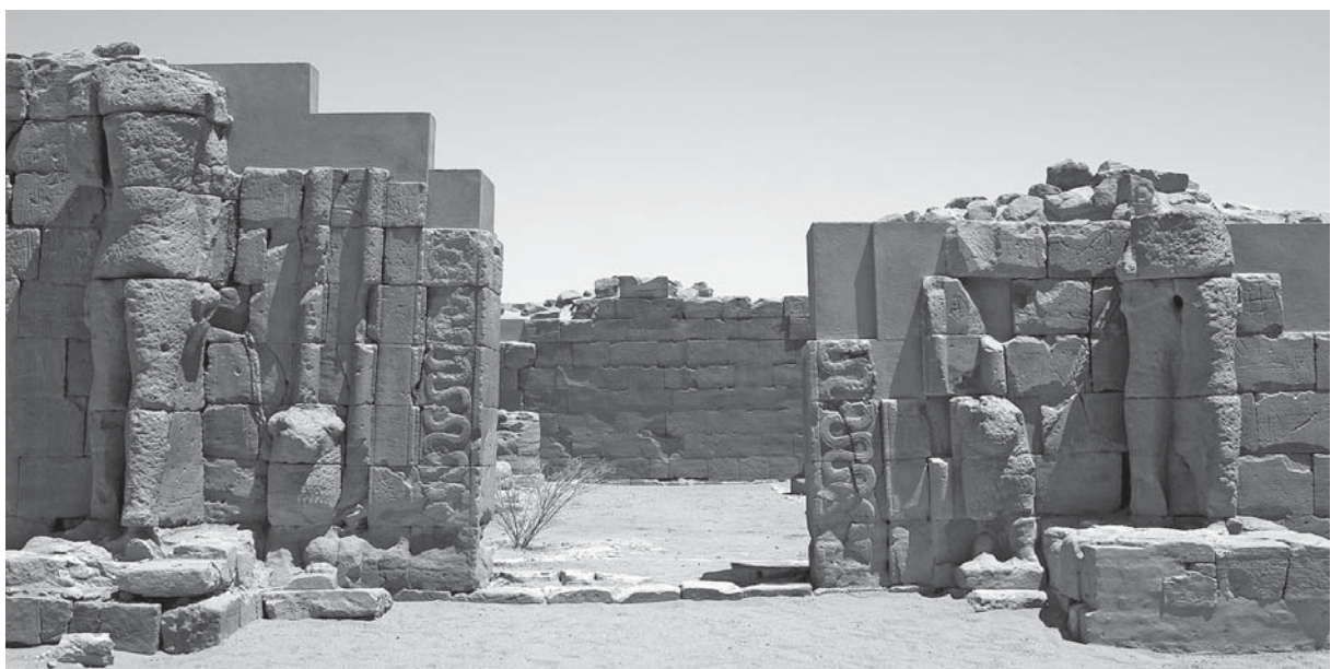
Abb. 30: Der zentrale Teil der sanierten Südfassade von Tempel 300 (vgl. Abb. 12).
