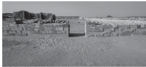
Abb. 11c: ... und nach Abschluss der Wiedererrichtung.
