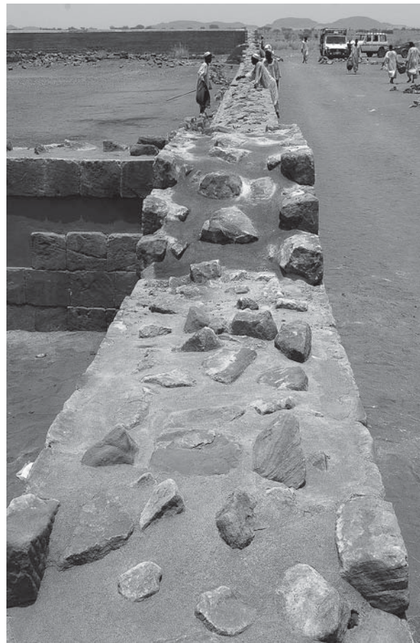
Abb. 3b: Ansicht nach Abschluss der Arbeiten 2008. Vorn die neu gestaltete Ecke der Mauern 304+305/E und 304/305 (s. u. im Text).
