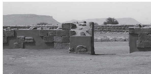
Abb. 16: Die Situation an der nördlichen Durchgangsseite nach ihrer Fertigstellung.
