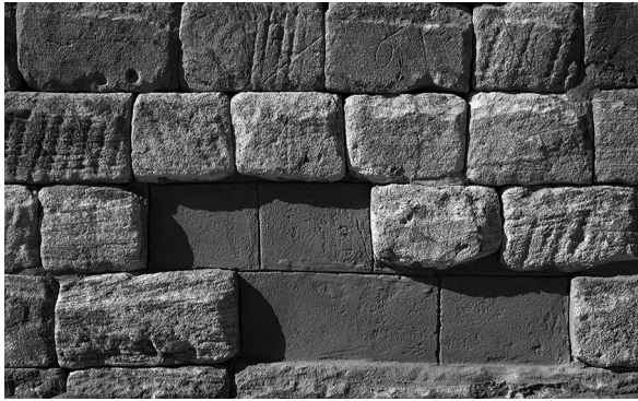
Abb. 25: Ausschnitt der Wand 307/304 mit Kennzeichnung der originalen Position und Abmessung nicht wieder verwendbarer Versturzböcke.
