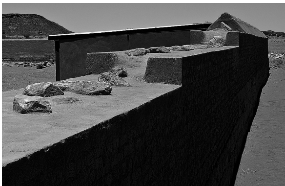
Abb. 6: Der neu gestaltete obere Mauerabschluss von 227/E mit nach Süden verlängerter Eselsrückenreihe und offener Mauerfüllung.
