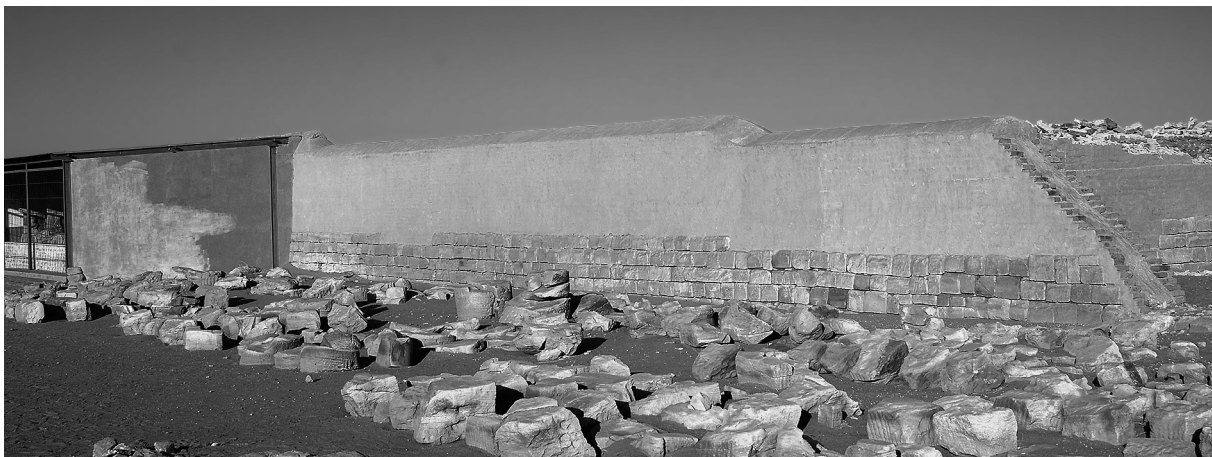
Abb. 4: Die Mauer 227/E mit dem Museum vor Beginn der Arbeiten.
