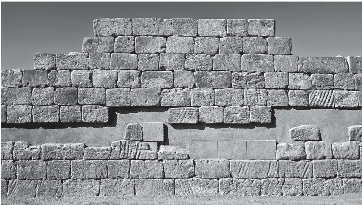
Abb. 26: Bereich der Südfassade mit aus der original erhaltenen Bausubstanz ausgebauten und durch Ziegel ersetzt Blöcken sowie der darüber verlaufenden Trennlage.
