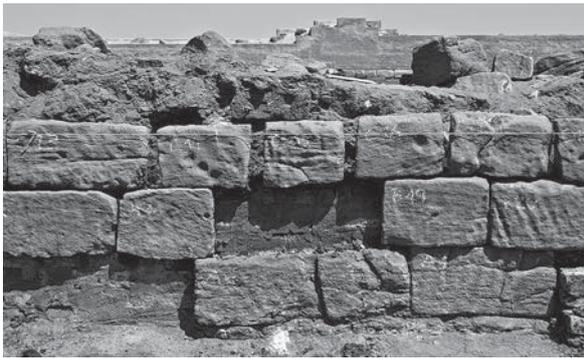
Abb. 27: Durch Kantenverwitterung entstandene (hier bereits vermittelte) Lückenbildung in einer durchgehenden Blocklage der Südfassade nach ihrem Wiedereinbau. In den beiden Blocklagen darunter mussten Originalblöcke teilweise durch Ziegel ersetzt werden.
