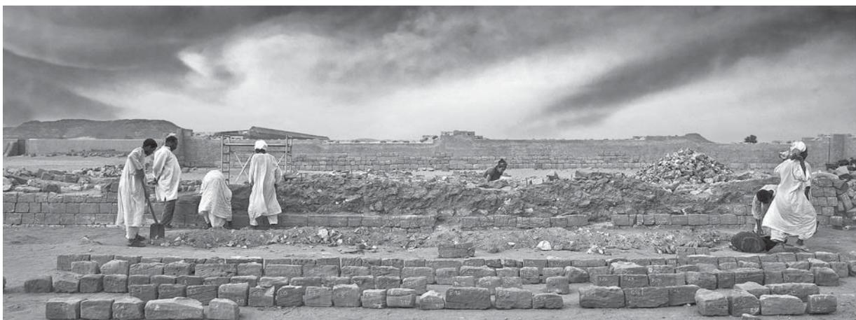
Abb. 14: Beginnende Wiedererrichtung nach dem Abtragen der Südfassade von Mauer 304/307.
