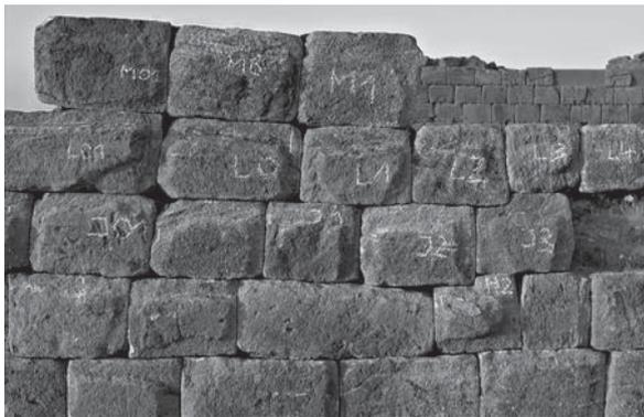
Abb. 21, 22: Originalgetreu rekonstruierte Reparaturzonen in der Wand 307/304.
