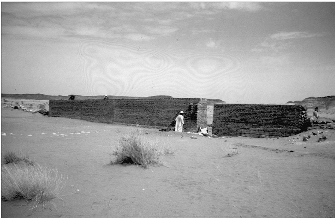
Die 1997 wieder aufgebaute Umfassungsmauer im Norden der Großen Anlage
