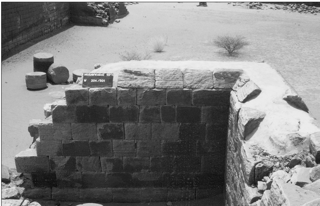
Abb. 7: Mit Mörtel abgedeckte Mauer (Neg.Nr. 1260-8)
