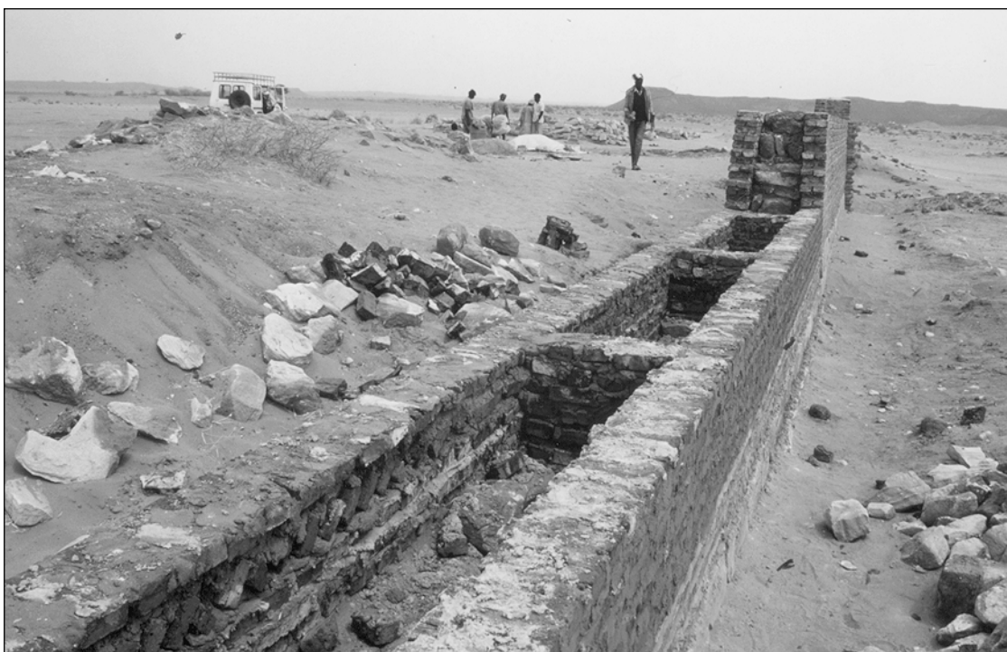
Abb. 10: Konstruktion der neuen Umfassungsmauer in Zweischalenbauweise (Neg.Nr. 1199-30)
