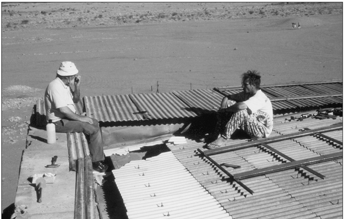
Abb. 1: Erste Reparaturarbeiten am Dach des Löwentempels 1995
