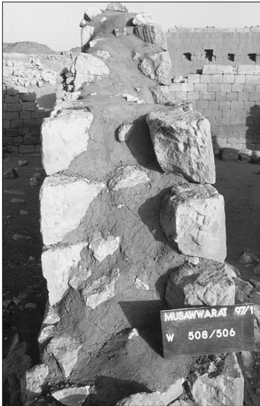
Abb. 8: Mit Mörtel abgedeckte Füllung einer Zweischalenmauer (Neg.Nr. 1259-21)
