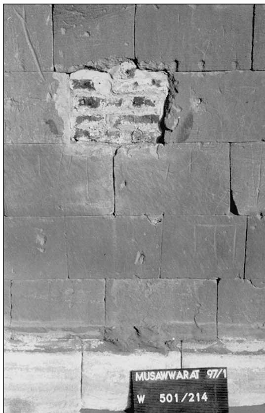
Abb. 5: Zugemauerter Mauerausbruch in der Wand 501/214 (Neg.Nr. 1259-17)
