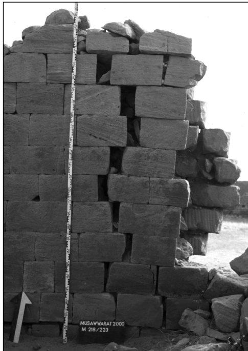
Abb. 6: Die einsturzgefährdete Wand 223/218. (Foto: 2000-18/6)
