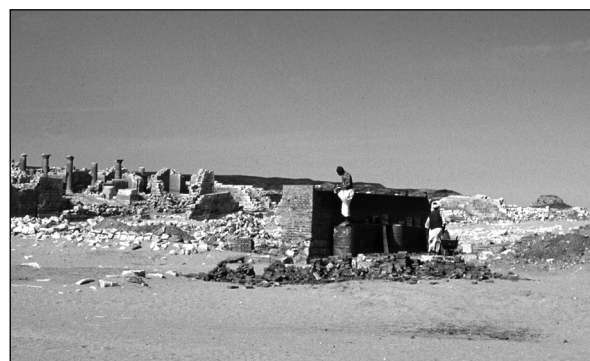
Abb. 8: Weiteres Teilstück der 2001 wieder aufgebauten Umfassungsmauer. (Foto: 2001-18/19)
