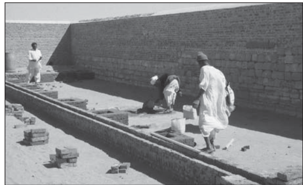
Abb. 12: Beginn der Arbeiten am Open Air Museum. (Foto: 2001-05/5)
