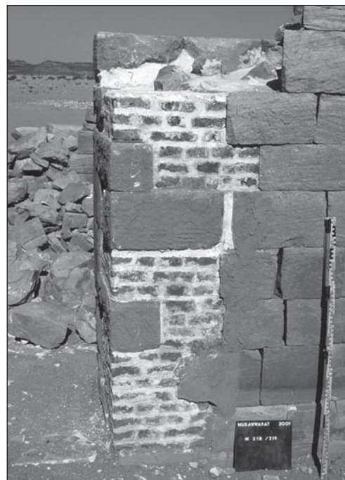
Abb. 5) Wiederaufbau einer Ecke der Mauer 218/219. Fehlende Blöcke sind in gebrannten Ziegeln ergänzt. (Foto: 2001-19/34)
