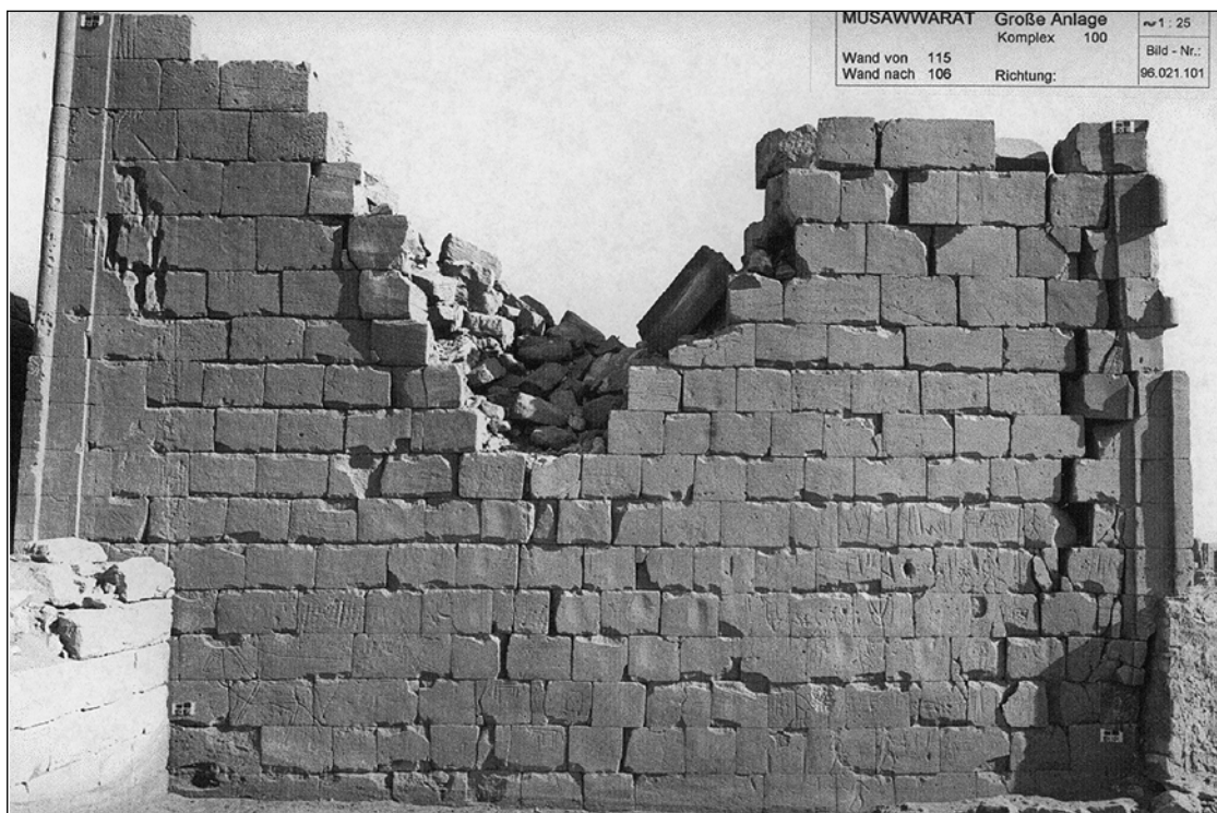
Abb. 7: Entzerrtes Meßbild der Wand 115/106 (Bildnr. 96.021.101; verkleinert)
