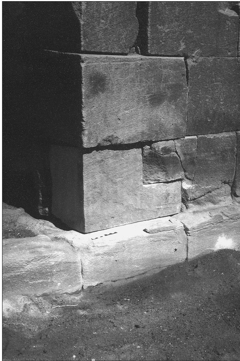
Abb. 2: Sanierte Fehlstelle am östlichen Fenster der Südwand des Zentraltempels (Wand 102/101S, Neg. Nr. 1074/2)
