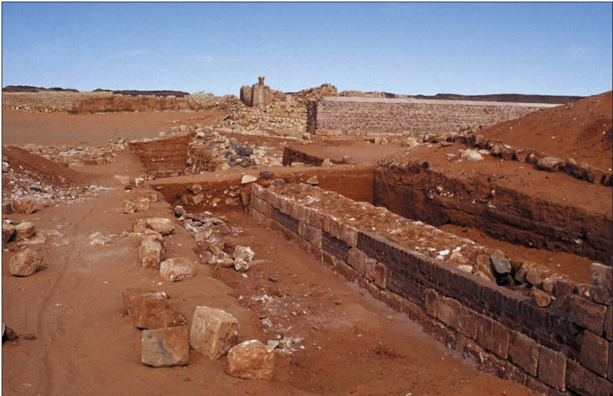
Farbabb. 1: Arbeiten an der Umfassungsmauer der „Großen Anlage“, (Foto: 2001-18/34).
