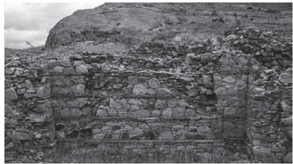
Abb. 21a: Zweischaliges Bruch- und Lesesteinmauerwerk in Matara (Foto: P. Wolf, 1996)
