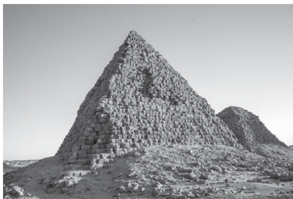
Abb. 22: Quadermauerwerk der napatianischen Pyramiden (Nuri) (Foto: P. Wolf, 2011)
