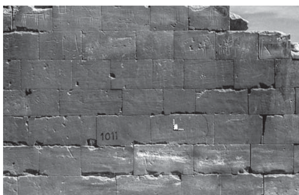
Abb. 19b: Mauerwerk der Ostwand im Raum 101 des Zentraltempels der Großen Anlage von Musawwarat (Foto: P. Wolf, 1998)
