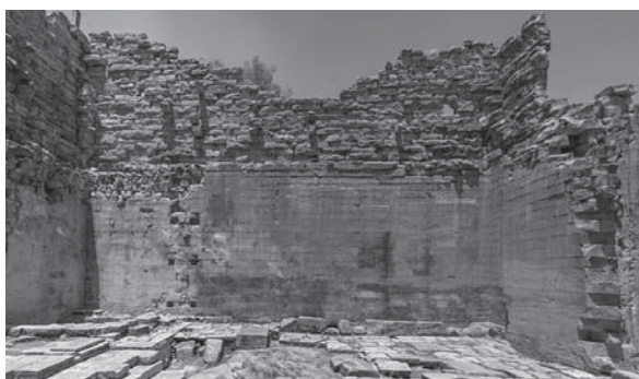
Abb. 20b: Zweischaliges Blockmauerwerk des Almaqah-Tempels in Yeha (innere Südwand des Almaqah-Tempels) (Foto: P. Wolf, 2008)
