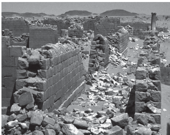
Abb. 20a: Zweischaliges Blockmauerwerk in der Großen Anlage von Musawwarat (Hochkorridor 214 von S) (Foto: P. Wolf, 1995)
