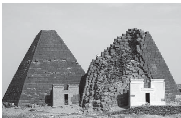
Abb. 23: Schalenbauweise der meroitischen Pyramiden (Meroe, Südfriedhof) (Foto: P. Wolf, 2006)
