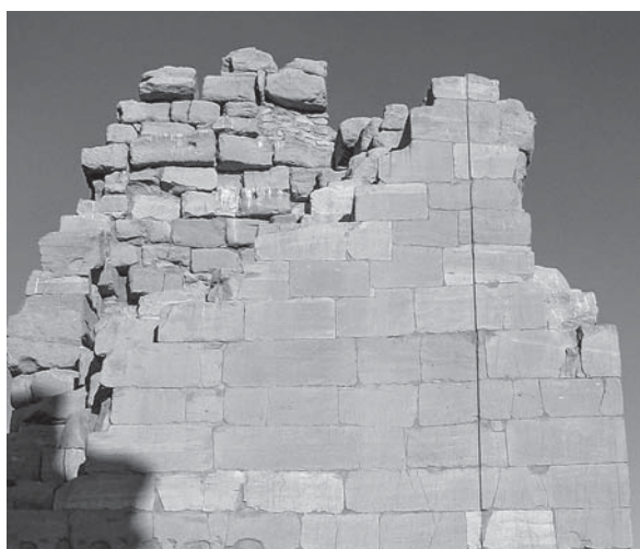
Abb. 19a: Mauerwerk des nördlichen Pylons des Amenophis III Tempels in Soleb (Foto: P. Wolf, 2005)
