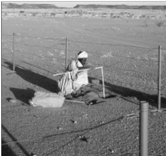
dedraht befestigt. Der Wind wird nun gebrochen, der Flugsand aufgehalten und nicht mehr mit voller Wucht gegen den Tempel geblasen (Foto 2) – Länge des Zaunes ca. 25 m.
