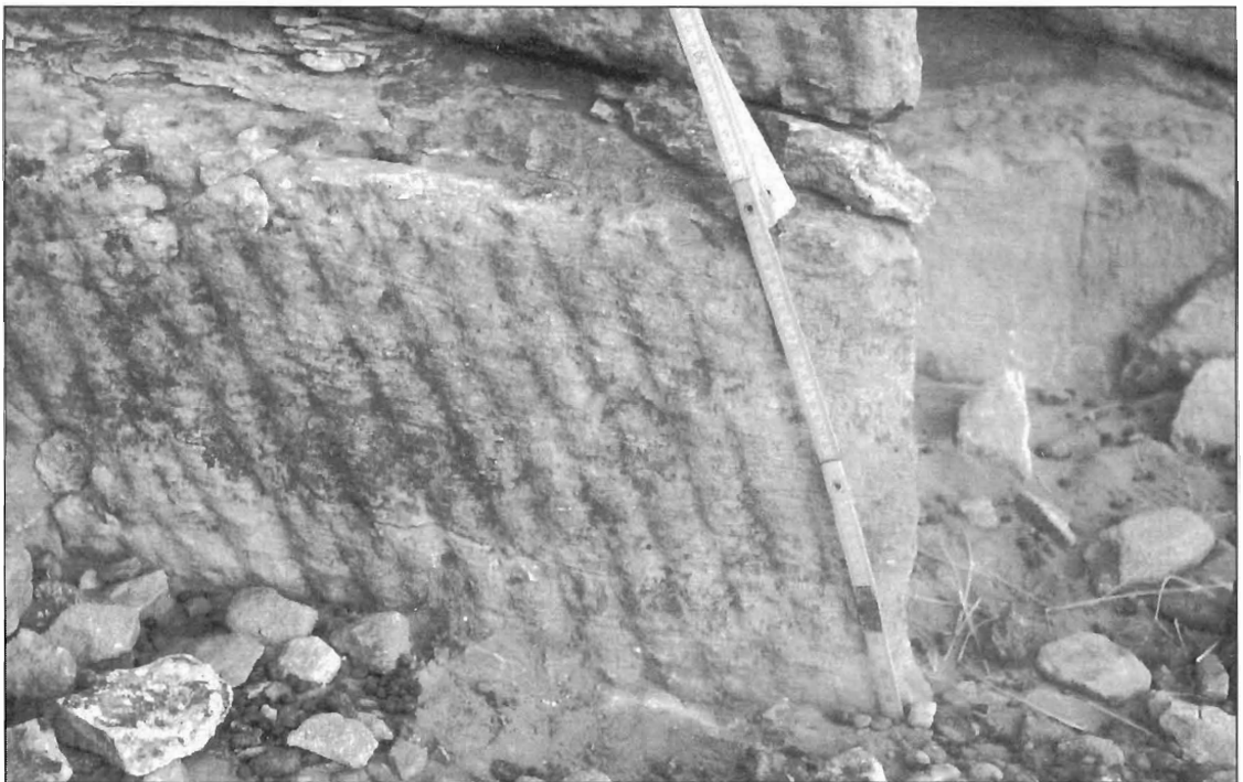
Abb. 6: Werkspuren des kräftigen Steinbruchmeißels: Ziemlich geregelt, Vortriebslänge pro Schlägelschlag 2–3 cm, Schrotlinien knapp 30 cm lang. Sog. Zweilinienschrot für eine Blockhöhe von knapp 0,40 m in einer Abteilung von Bruch 3a.
