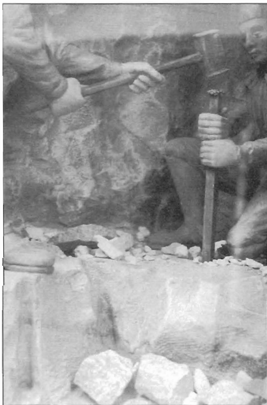
Abb. 9: Schlagbohren: 2-Mannbetrieb; deutlich werden Bohrersteuerung, gefahrgeneigte Arbeit, Wirkung des Bohrfaustels auf das Bohrerende (scharfer „Bart“) und für den jeweiligen Einsatzzweck erforderliche Bohrerlänge. Bisheriges Erstdatum: 1588 (Bohrlöcher beim Steinbruchbetrieb in Tolfa bei Rom). Diorama im Deutschen Bergbau-Museum, Bochum.
