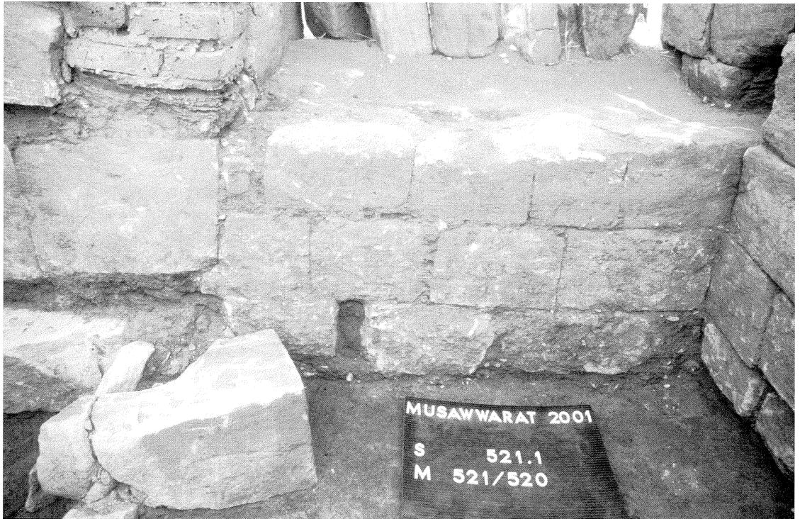
Abb.3: SE-Ecke des Hofes 521. Mit der Mauer 521/527 (rechts) verzahnte Schwelle des Durchganges 521-520. Am nördlichen Abbruch deutliche Ausbäckung für die Einpassung der jüngeren Mauer 521/520 (links oben). Im Vordergrund links heruntergefallener Eckblock des abgerissenen Gebäudes, links dahinter das Fundament des Gebäudes unter der Mauer 521/520.
