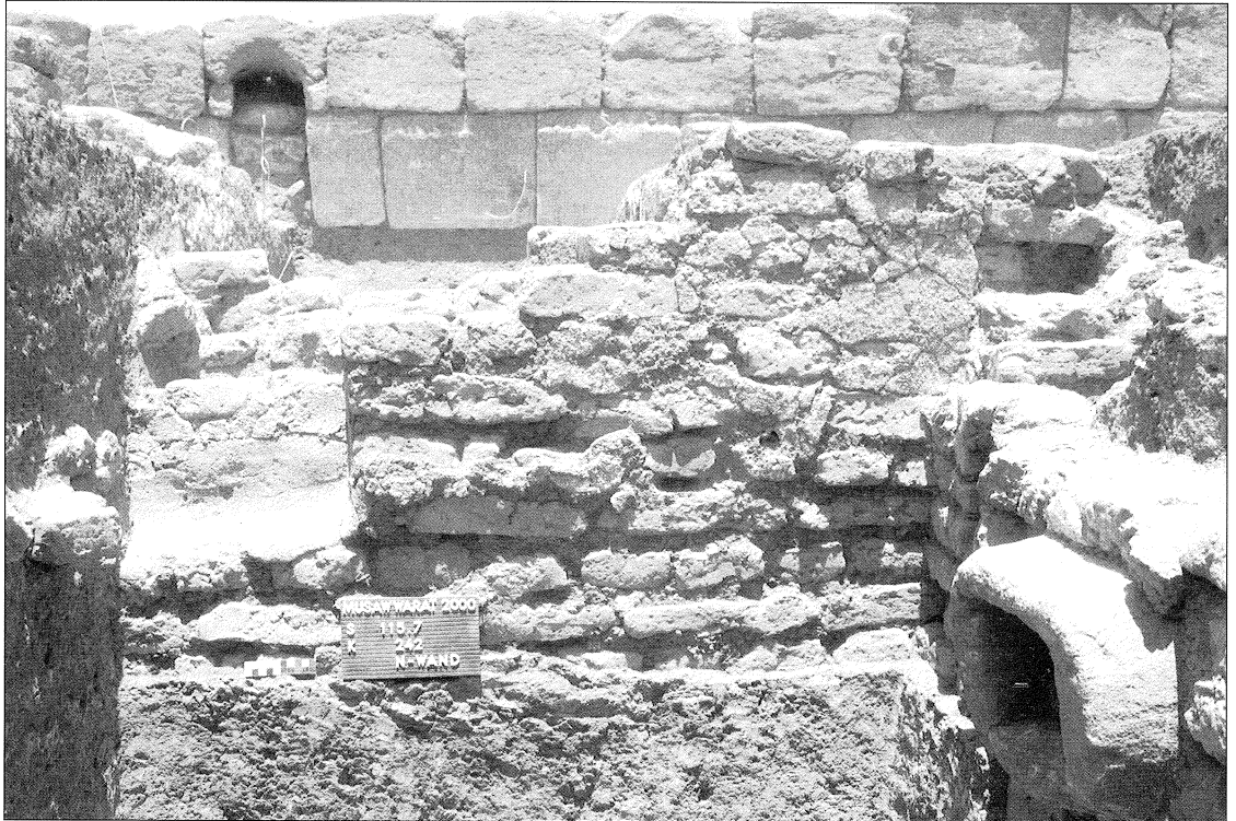
Abb.2: Innenansicht der NE-Ecke des Wasserbeckens: Links am Mittelsteg der kaskadenartige Zulauf (Osthälfte), oben dahinter der Mauerdurchlaß K 488, der ersteren speiste. Rechts der Mündungsblock der Sandsteinwasserleitung K 223. An der Nordwand Reste des Kalküberzuges, im unteren Bereich zum Schutz dieses Putzes nicht entfernte Füllsedimente.
