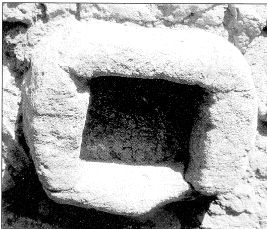
Abb.5: Ansicht des Mündungsblockes der Wasserleitung in der Ostwand des Beckens. Soble lippenartig zugearbeitet (oder erodiert?), annähernd quadratischer Innenquerschnitt. Rissbildung v.a. in den unteren Ecken erkennbar, keine Fugen!
