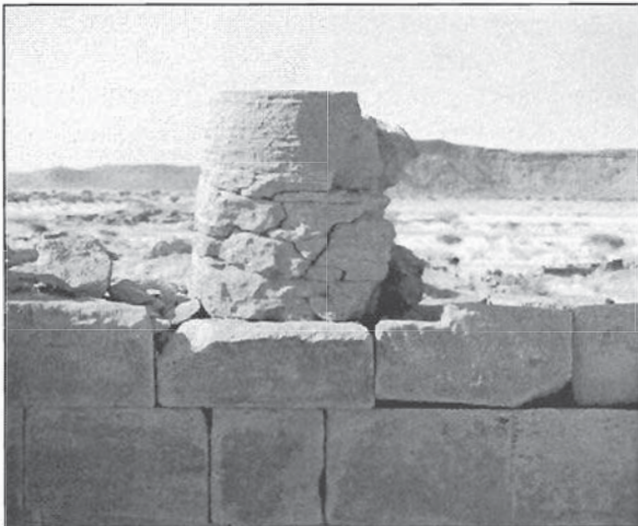
Abb.7: Vorhalle 516a, Stumpf der Ecksäule auf der südlichen Brüstungsmauer.
