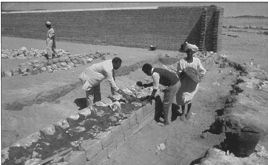
Abb. 1: Unsere sudanesischen Mitarbeiter beim Aufmauern der Umfassungsmauer (Neg. Nr. 1277/36).
